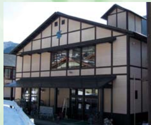
⑤馬瀬小学校 平成3年に建設された本格木造建築の校舎。平成19年度、学校花壇コンクール(FBC)で「名譽大賞」を受賞。
